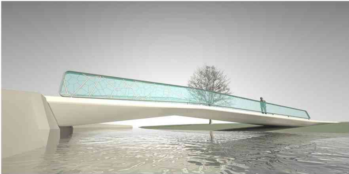
Figuur 70: Voor bruggen zoals deze ‘Dragonfly’ (bron: Royal Haskoning DHV) biedt de CUR96 richtlijn [5] houvast bij het ontwerp in composiet
